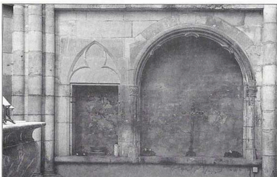
Pl. 14. Fig. 1 : La fenêtre de la façade du bras nord. Fig. 2 : La piscine du chœur.
