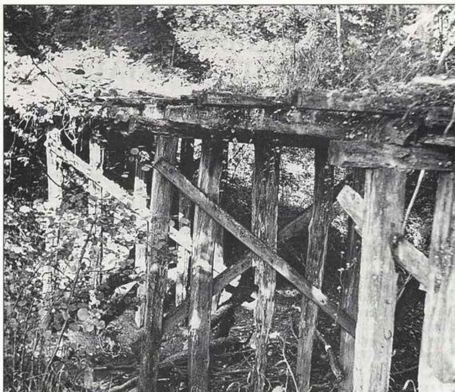
Le pont Bancelin, sur le territoire du Claon, aurait été édifié à l'emplacement de Pont-Verdunois
