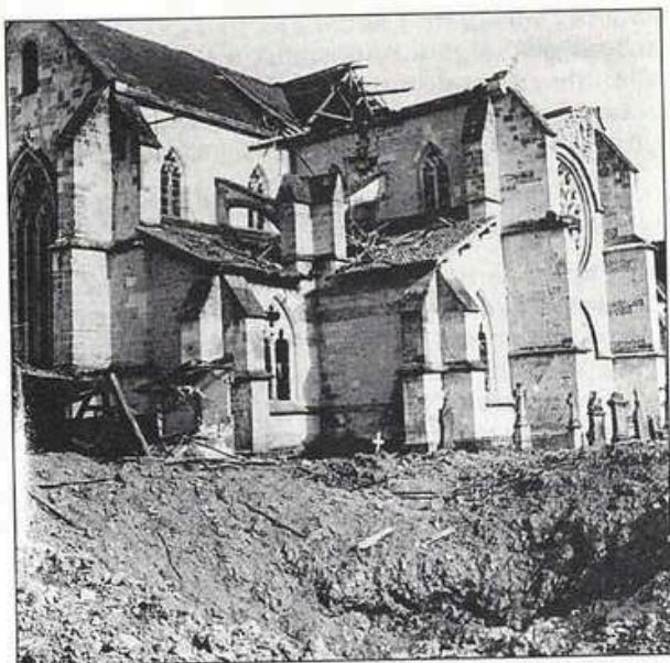
La partie nord-ouest est détruite.
